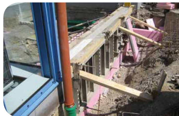
Arbeiten am Fundament
