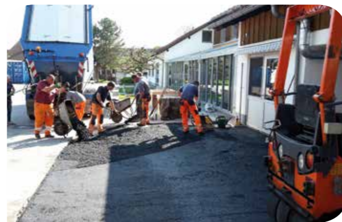
Asphaltierung vor der Spülküche und vor dem Eingang
